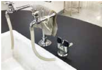
写真3 理科室に設置されている水道とガスの元栓
