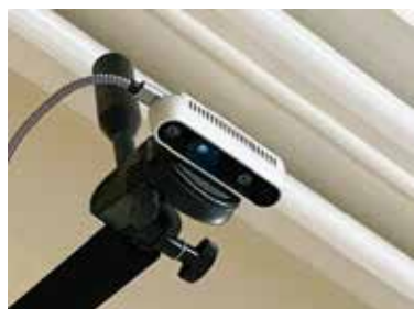
写真3 天井近くに深度センサーを設置
